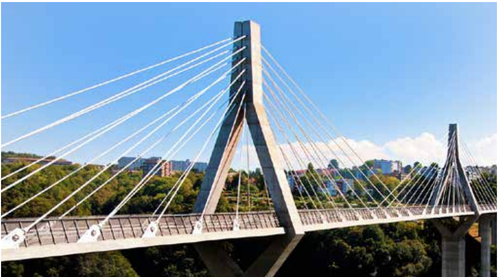
Poyabrücke in Fribourg FR
